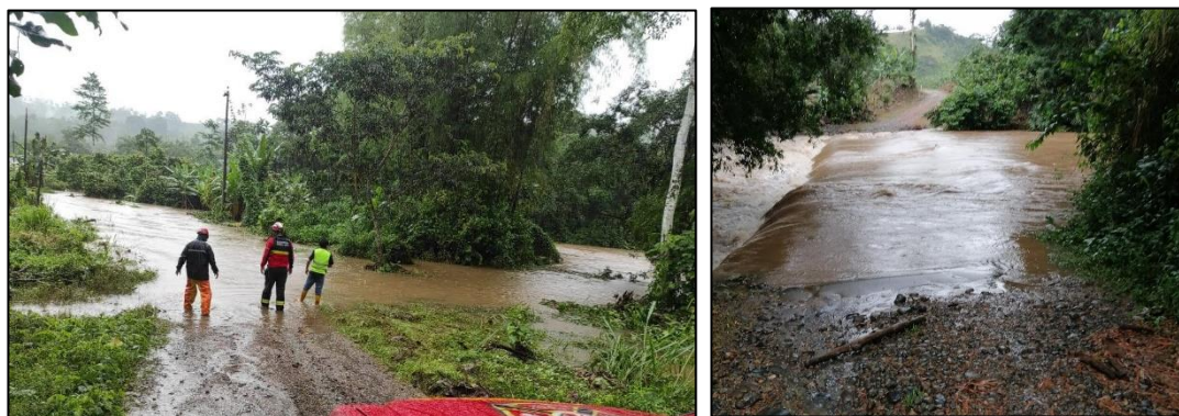
Gráfico 16 Imágenes de Inundación en San Francisco de Silanche por desbordamiento de Río Silanche
